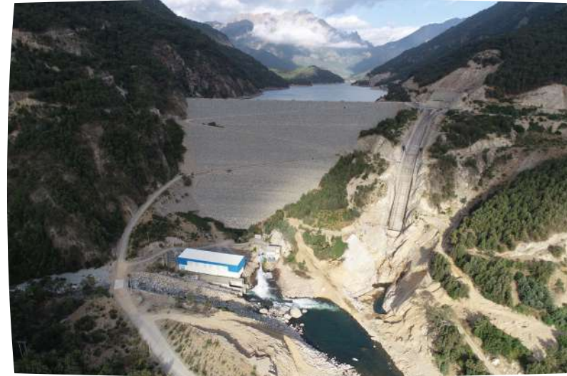
Vista aérea del muro del embalse Ancoa.
